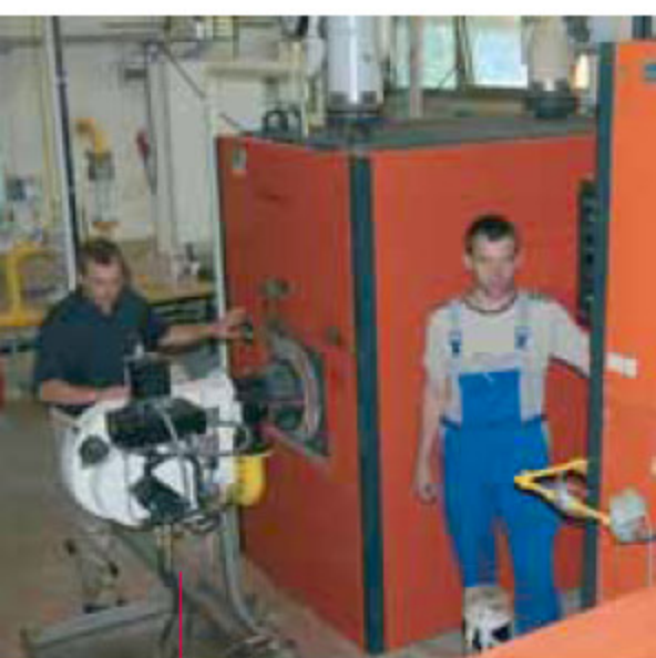
Günther Geese und Olaf Deppe in der alten Heizzentrale. / Günther Geese and Olaf Deppe in the old heat station.
