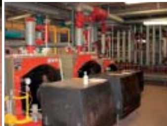
... ersetzt die alten Heizkessel.
