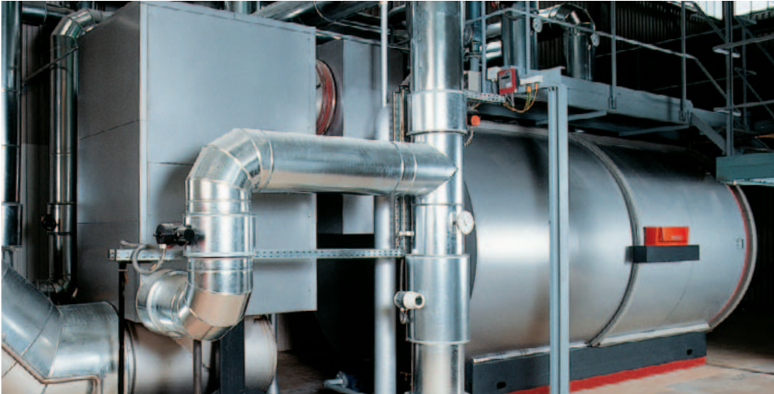
Der Vitomax 200 mit nachgeschaltetem Abgaswärmetauscher und 4,99 MW dient als Führungskessel zur Hauptwärmeversorgung und Spitzenlastabdeckung der gesamten Heiz- und Prozesswärmeenergieversorgung der KWS Saat AG.
