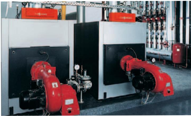
Bei Ingersoll in Haiger sorgen zwei Vitocrossal 300 mit jeweils 895 kW für wohlige Wärme und niedrige Betriebskosten.
