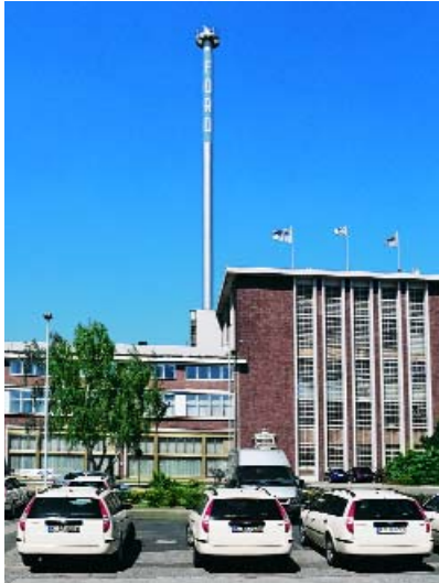
Das Heizwerk der GEW RheinEnergie auf dem Gelände der Ford-Werke AG in Köln-Niehl
