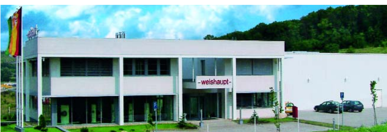
Eingangsbereich mit Lagerhalle
