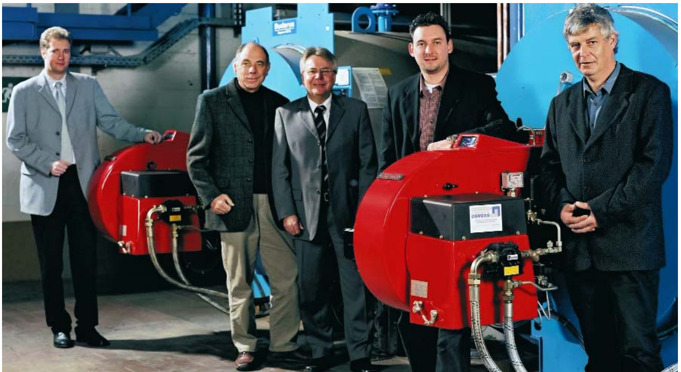
In der neuen Heizzentrale der International University Bremen (v.r.n.l.): Dipl.-Ing. Heiner Suer (Prokurist der Firma Technische Gebäudeausrüstung Johann Osmers, Bremen), Ing. Andreas Pape (Facility Management der Universität), Günter Schwarz (Leiter unserer Niederlassung Bremen), Dipl.-Ing. Hermann Sanders (Ingenieurbüro Bruns & Partner, Bremen) und Hauke Petermann (Kundendienstleiter unserer Niederlassung Bremen)
