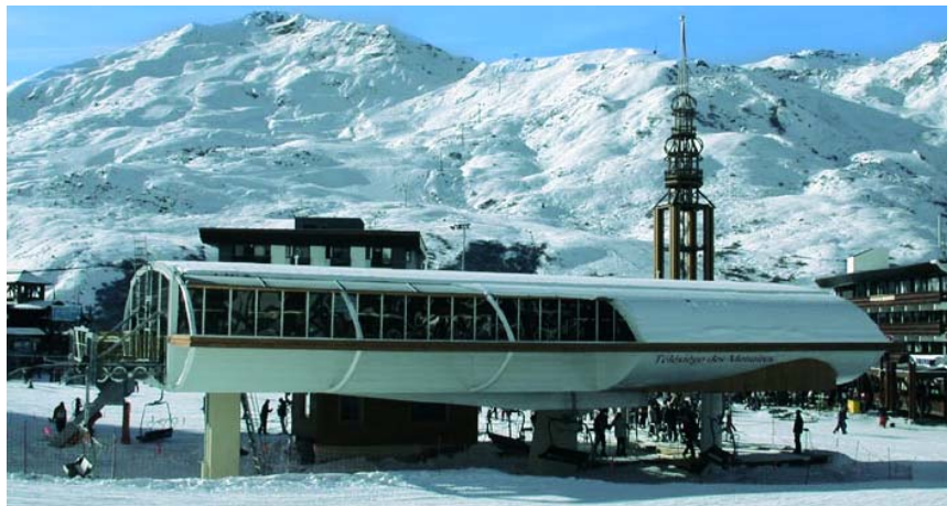
Eine der futuristisch anmutenden Gondelstationen des 1.850 Meter hoch gelegenen Wintersport-Ortes "Les Menuires" in der Region Savoyen
