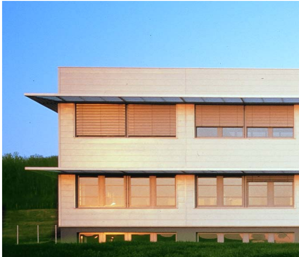
Der architektonisch anspruchsvolle und modern ausgestattete Neubau unserer ungarischen Tochtergesellschaft in Budapest
