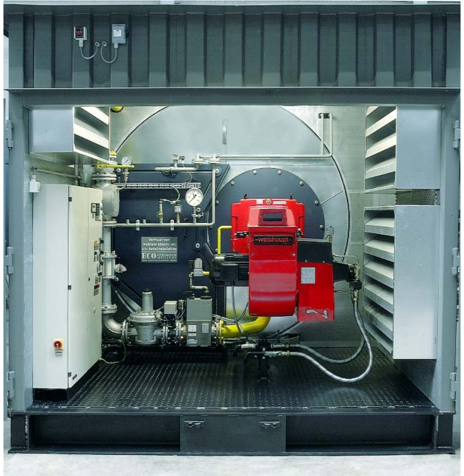
Weishaupt-Zweistoffbrenner in einer der zahlreichen mobilen Kesselanlagen der Eco Ketelservice Verhuur BV
