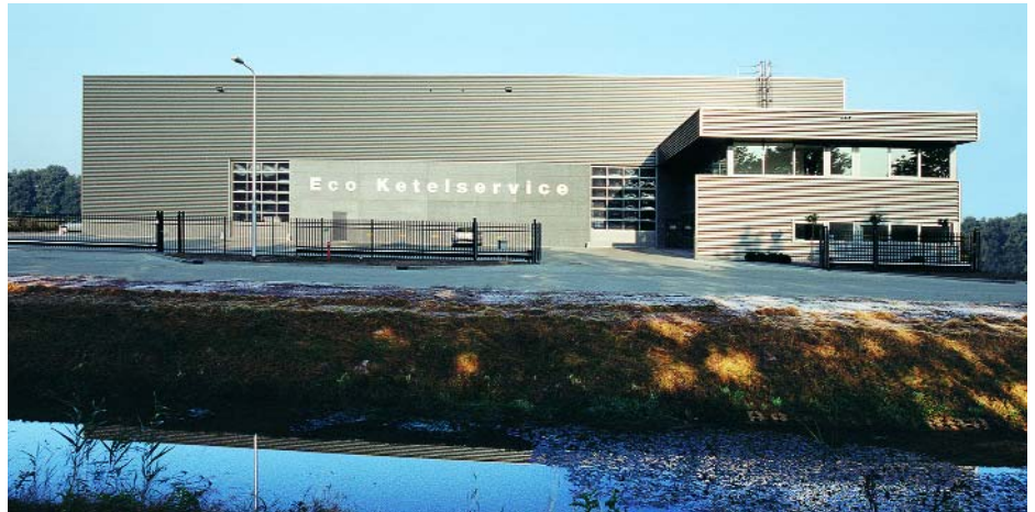
Die Werksanlagen der Eco Ketelservice-Gruppe im niederländischen Tilburg
