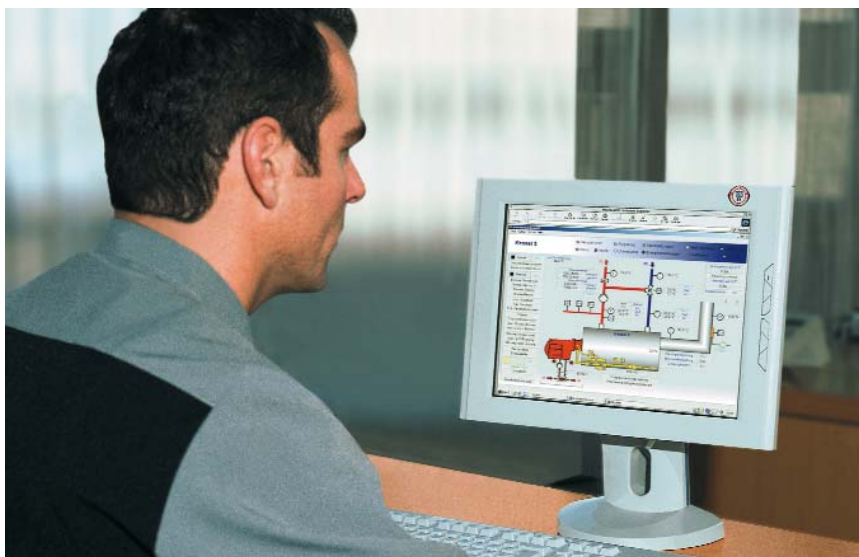
Gebäudeleittechnik ProGraNT: der zentrale Leitrechner überwacht standortunabhängig alle verbundenen gebäudetechnischen Anlagen
