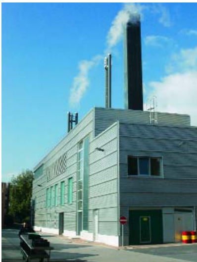
Die Heizzentrale der KWS Saat AG wurde grundlegend modernisiert
