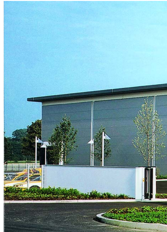
Neubau unserer Niederlassung Freiburg: neben Verwaltungs- Feuerungs- und Heizungstechnik untergebracht
