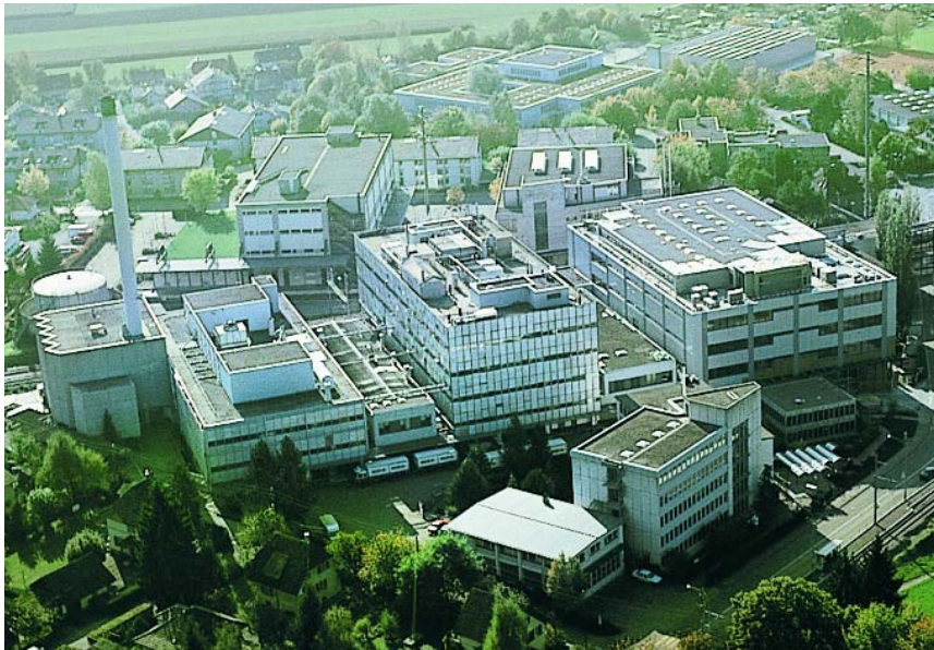
Die Werksanlagen des Lebensmittelherstellers Haco AG im schweizerischen Gümligen bei Bern
