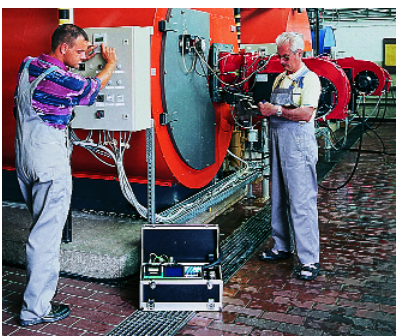
Über die Anzeige- und Bedieneinheit werden die neuen Brenner problemlos eingestellt
