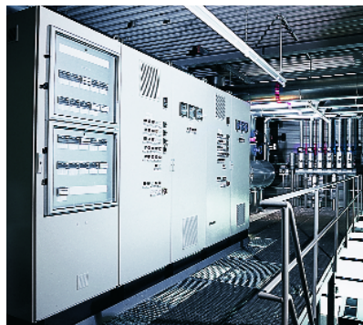
Eine Weishaupt-Schaltanlage übernimmt die gesamte Steuerung
