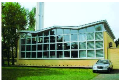
Moderne, transparente Architektur: das Heizwerk Mariahof in Trier
