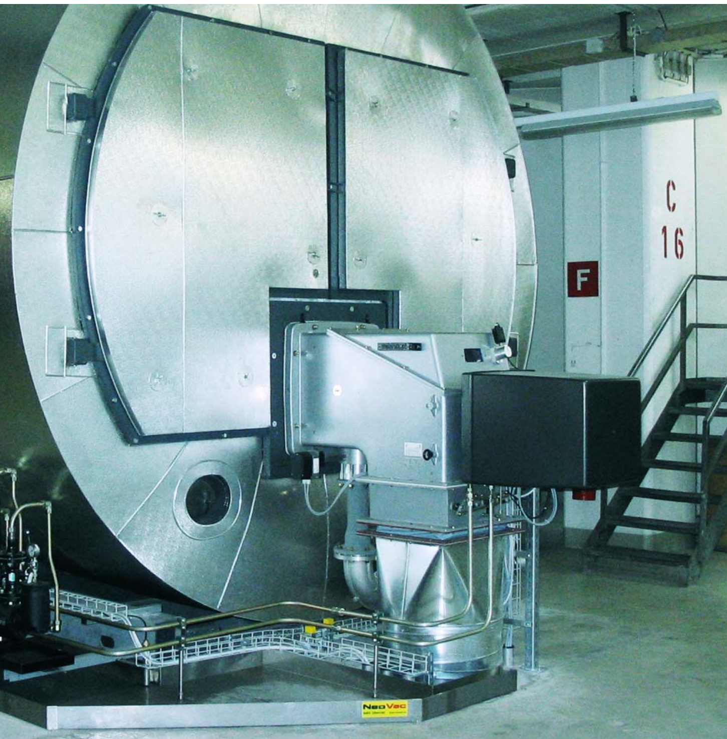
Weishaupt-Zweistoffbrenner multiflam® in Duobloc-Ausführung mit feuerrauminterner Rezirkulation nach Schweizer Luftreinhalte-Verordnung. Der Brenner ist ausgestattet mit Optimierungstechnologien wie Drehzahlsteuerung und O 2 -Regelung
