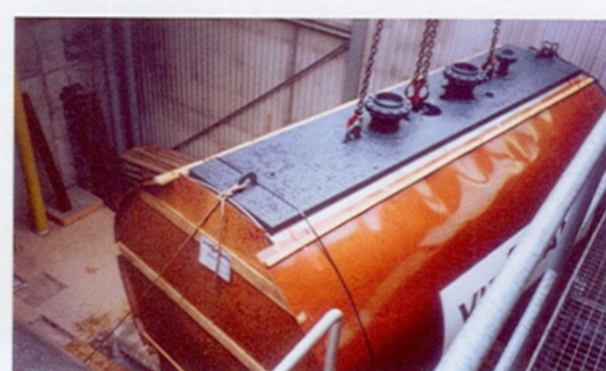
Der Kessel musste mittels Kran durch das extra für diesen Zweck geöffnete Dach in das Gebäude eingebracht werden.
